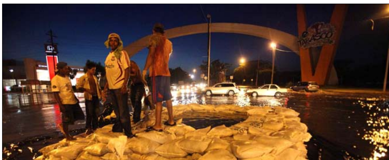
Cientos de habitantes de la capital tabasqueña aprovecharon que el mal tiempo dio una tregua y se organizaron masivamente para levantar murallas con costales llenos de arena, en un intento por contener las aguas de los ríos Samaria y Carrizal, que reciben el desfogue de las presas del Alto Grijalva: Angostura, Chicoasén, Malpaso y Peñitas, y que están a punto de desbordarse con el riesgo de inundar a Villahermosa y municipios aledaños. RML. Foto: Agencia EL UNIVERSAL/ Jorge Serratos
